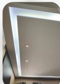
Sanca - Rasgo Iluminado
